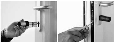
5 Spostare la manopola interna sull'albero fino alla misura desiderata. Assicurarsi che la distanza tra la manopola rotante e la cerniera sia di almeno 1 mm. Quindi, fissare la manopola rotante mediante la vite senza testa.
